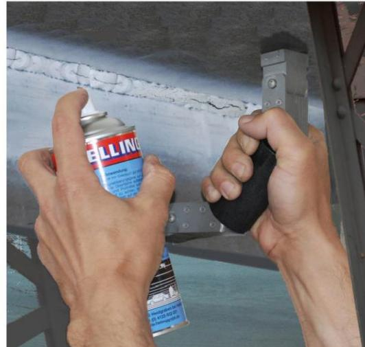
Проверка сварных соединений моста с помощью черной магнитопорошковой сусpenзии BW 333 и белой фоновой краски NR 104 A
